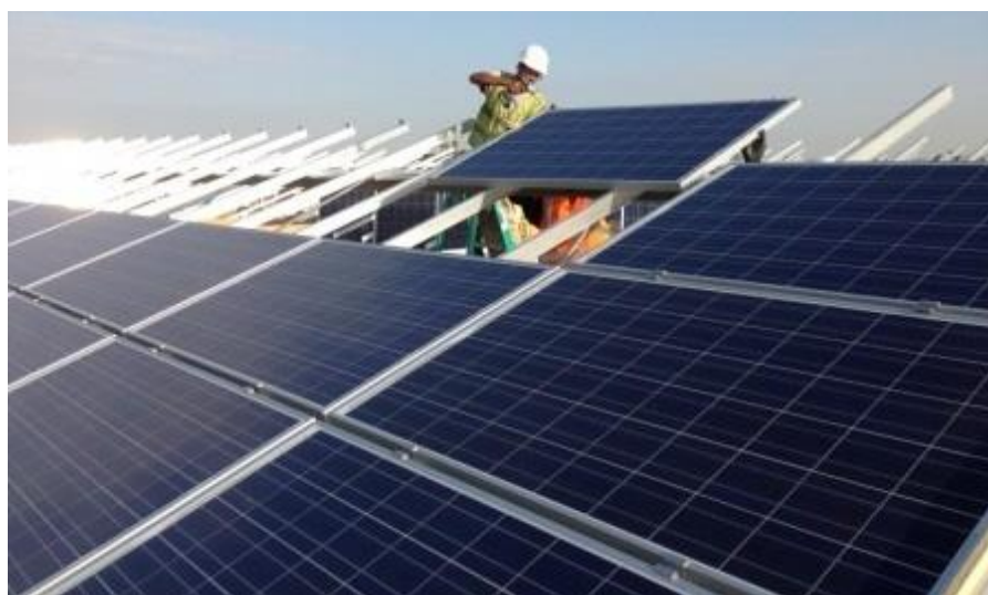
Figure 31. Exemple de mise en place des modules sur les structures
