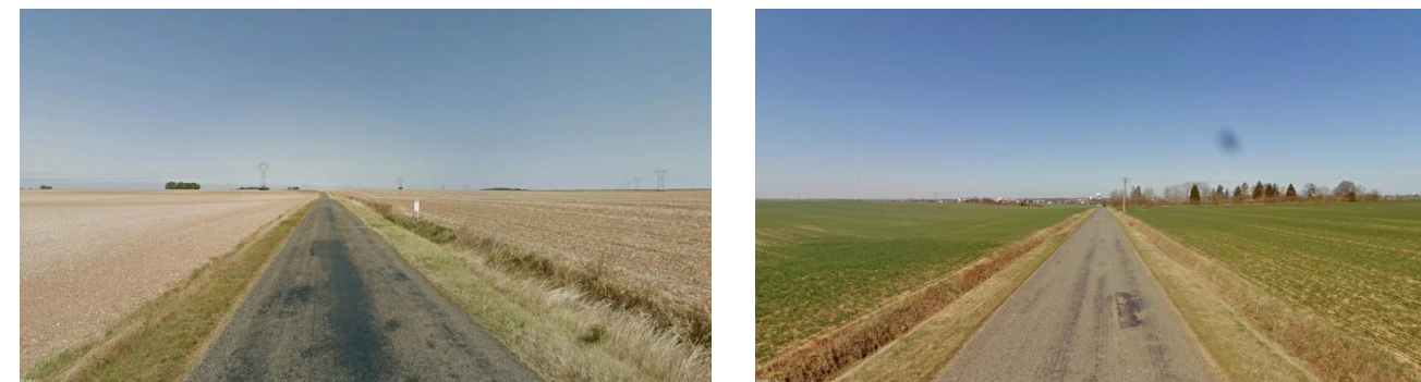
Photo 6: Fossé sur la route départementale N°68
