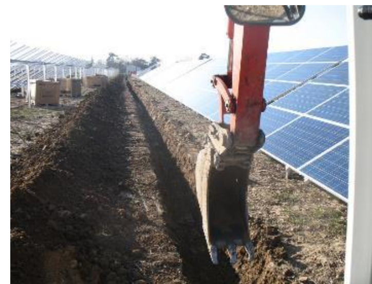
Figure 32. Exemple de tranchée entre deux tables photovoltaïques
