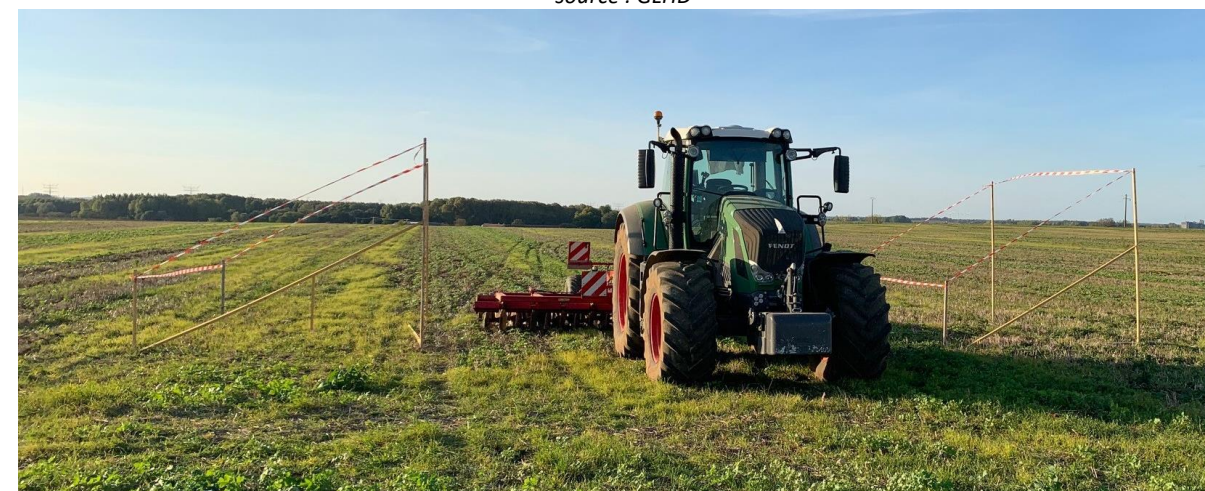
Photo 3 : Matérialisation sur le terrain de l'implantation des structures Source : GLHD Octobre 2021
