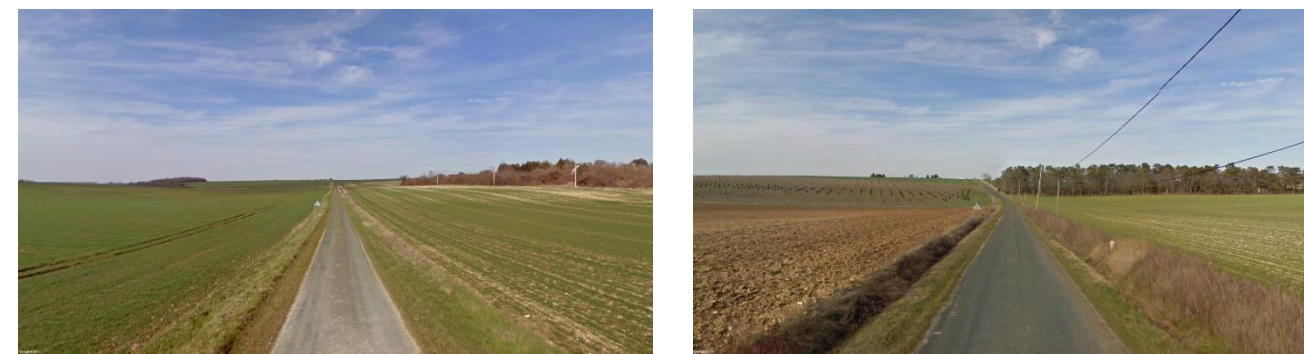
Photo 7: Fossé sur la route départementale N°131
